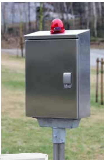
Flygt FGC 211 med utomhuskapsling IP 65 av plast eller rostfritt stål. I skåpet finns pumpstyrning,
