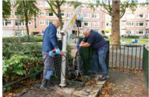
De Flygt Concertor wordt uit de put gehaald voor inspectie.
