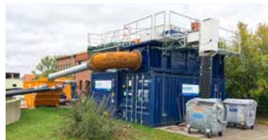
Rechen- und Container-Anlagen inklusive M&C wurden geliefert und installiert. Die Gesamtkapazität ist auf 900 m<sup>3</sup>/h ausgelegt.
