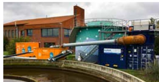
Die Kläranlage Empede wird vom Abwasserbehandlungsbetrieb Neustadt am Rübenberge betrieben. Nach der Sanierung der Rechen-, Sand-, und Fettfanganlage wird die Mietanlage wieder vollständig abgebaut.
