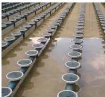
Sistemas de aireación para agua residual
