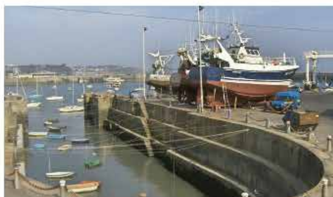
Drenaje de diques secos
