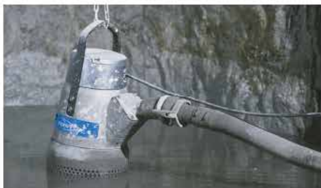
Achique de agua subterránea
