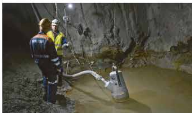
Achique de agua subterránea
