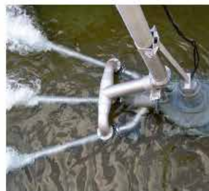
Sistemas de aireación para agua residual
