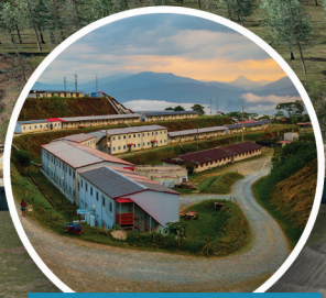
Campamento minero: Aguas, Incendio y HVAC.
