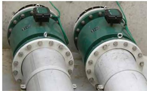
Flujómetros MagFlux son fabricados con acero al carbono y acero inoxidable para las conexiones y alineaciones en gomas duras o suaves PTFE/PFA.
