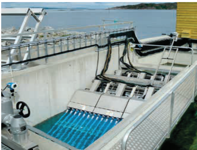
Equipo de luz UV Wedeco en canal abierto de la serie Duron instalado en una piscifactoría de Noruega
