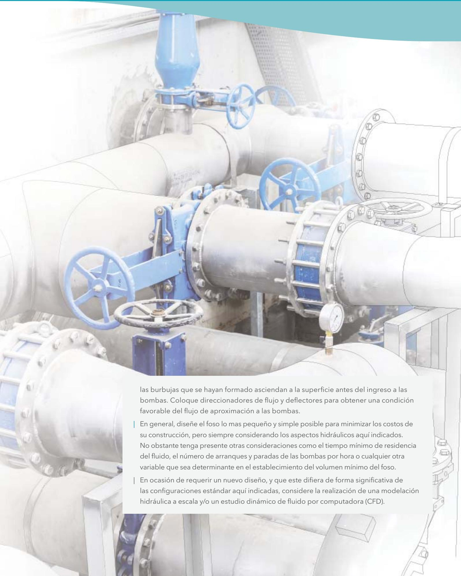
las burbujas que se hayan formado asciendan a la superficie antes del ingreso a las bombas. Coloque direccionadores de flujo y deflectores para obtener una condición favorable del flujo de aproximación a las bombas.
