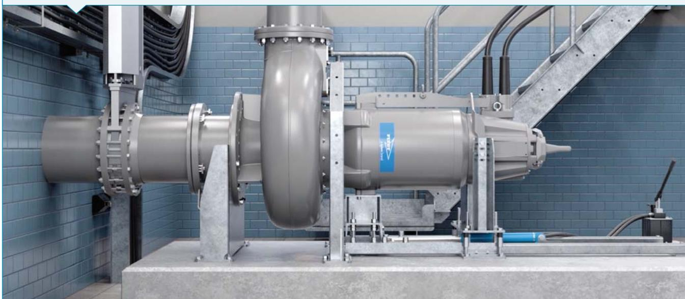
La imagen anterior muestra una bomba instalada de forma horizontal en un foso seco, con una línea de succión con su correspondiente soporte, una válvula de compuerta, y un riel o trineo de servicio. Este es un ejemplo del tipo de arreglo que debe colocarse en una fundación de concreto.
